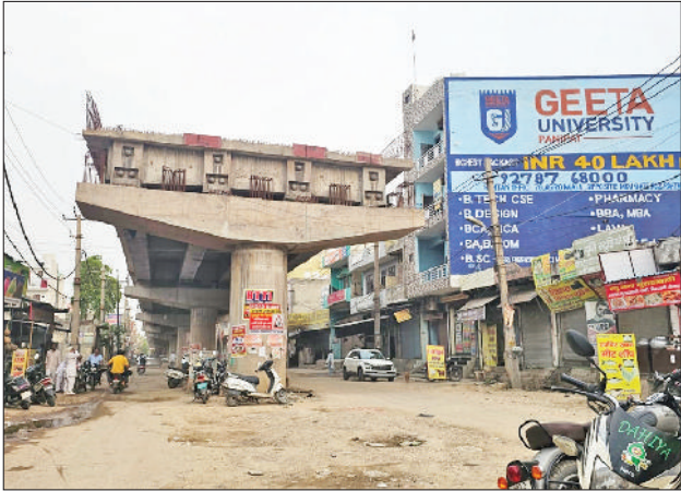
रोहतक। सुखपुरा चौक पर निर्माणाधीन पुल।
